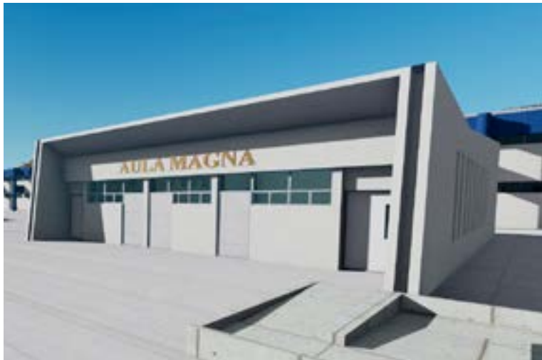
Aula Magna con capacidad para 220 espectadores, cuenta con un avance de obra del 90% y el 100% de equipamiento.
