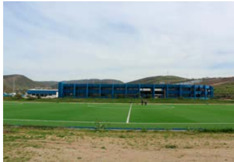
Cancha de Fútbol Soccer con medidas oficiales y pasto sintético cuenta con un avance del 95%, falta equipamiento e infraestructura complementaria como: gradas, vestidores, porterías con sus accesorios complementarios.
