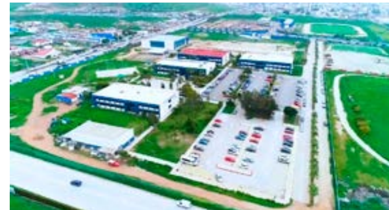
Proyecto de iluminación exterior y circuito cerrado en todo el proyecto aeroespacial, registra un avance del 5%.
