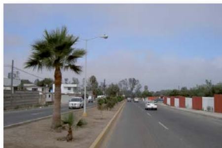
Figura 2.34. Boulevard Tecnológico concluido, hoy es utilizado por la comunidad ensenadense.
