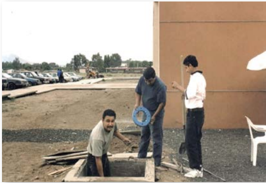
Figura 2.10. Instalación del cableado.
