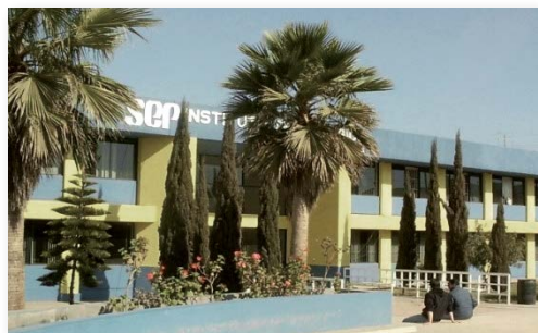
Figura 4.34. Primer edificio con colores institucionales.
