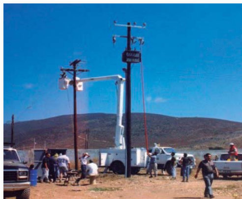
Figura 2.9. Otra vista del montaje de la subestación.
