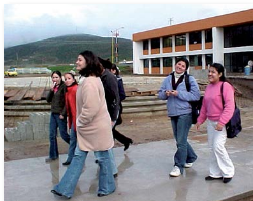
Figura 3.13. Construcción de la explanada.
