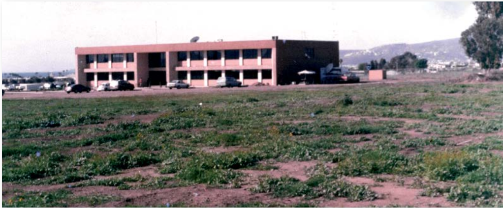
Figura 1.9. Vista completa del primer edificio, terminado en color marrón.
