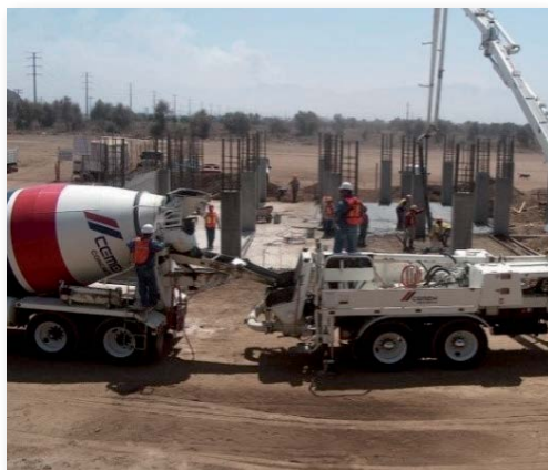
Figura 5.9. Cimientos del Edificio 400.
