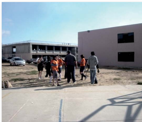
Figura 5.8. Edificio 200 y Edificio 300, planta alta inconclusa.
