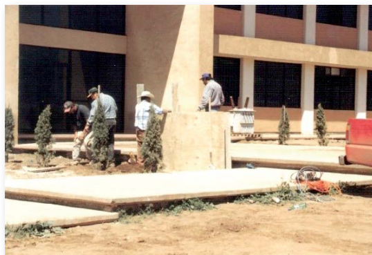
Figura 1.8. Terminación del primer edificio, después denominado como Edificio 100.
