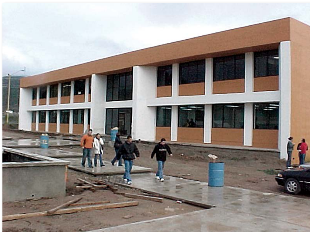
Figura 3.15. Segundo edificio académico departamental terminado.
