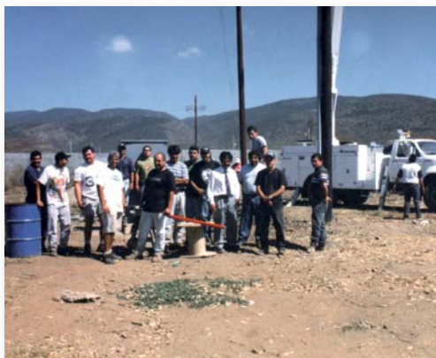
Figura 2.8. Alumnos de Electromecánica colocando la subestación eléctrica.
