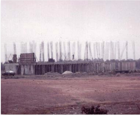
Figura 1.6. Inicio de la construcción.
