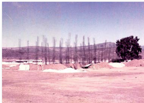
Figura 1.5. Iniciación de la construcción del Instituto Tecnológico de Ensenada.
