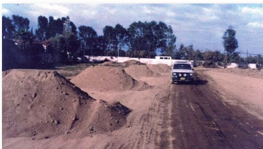
Figura 2.33. La construcción del Boulevard Tecnológico.
